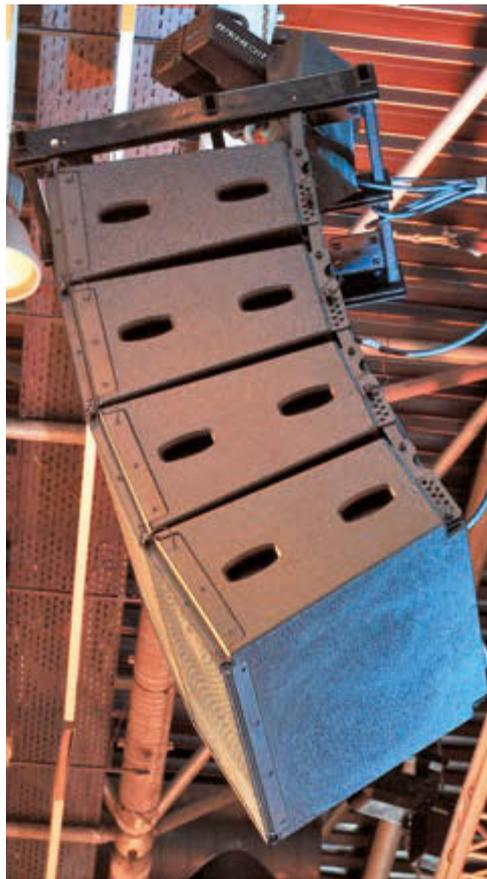
Obwohl die Deckenhöhe mehr als ausreichend wäre – die Beschränkung auf vier Elemente eines Arrays lassen häufig den Druck in den Mitten vermissen
