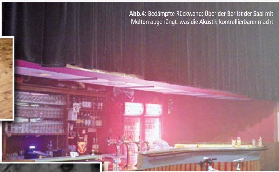
Abb.4: Bedämpfte Rückwand: Über der Bar ist der Saal mit Molton abgehängt, was die Akustik kontrollierbarer macht
