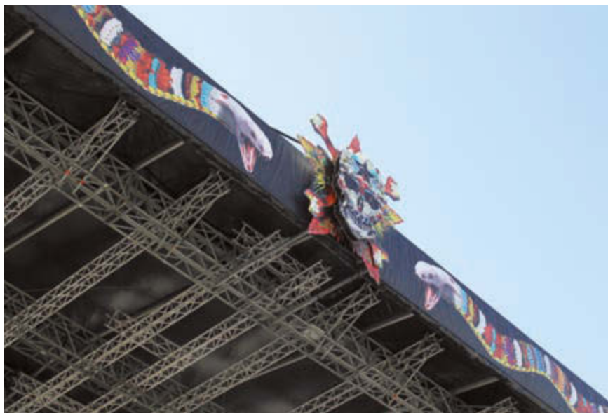
3D-Totenkopf-Logo mit LED-Technik in rund 18 Metern Höhe in der Mitte des Bühnendachs – daneben befinden sich „passive“ Schlangen, die von außen angeleuchtet werden
