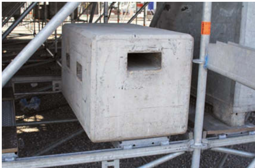
20 Tonnen Zusatzballast in Stuttgart: Einer der Betonblöcke im Unterbühnenbereich, um Windlasten abzufedern
