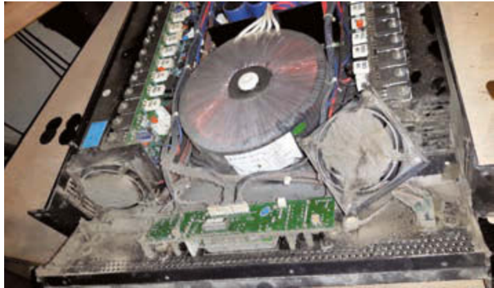
Bild 15: Und sie laufen und laufen – so sah es nach acht Jahren Dauerbetrieb in einer Düsseldorfer Diskothek im Gehäuse einer IMG Stageline STA-2200 aus (die Kühllüfter sind fast dicht, dennoch funktionierten alle Endstufen ohne Ausfall – das darf ruhig lobend erwähnt werden und spricht für die thermischen Reserven der Konstruktion)
