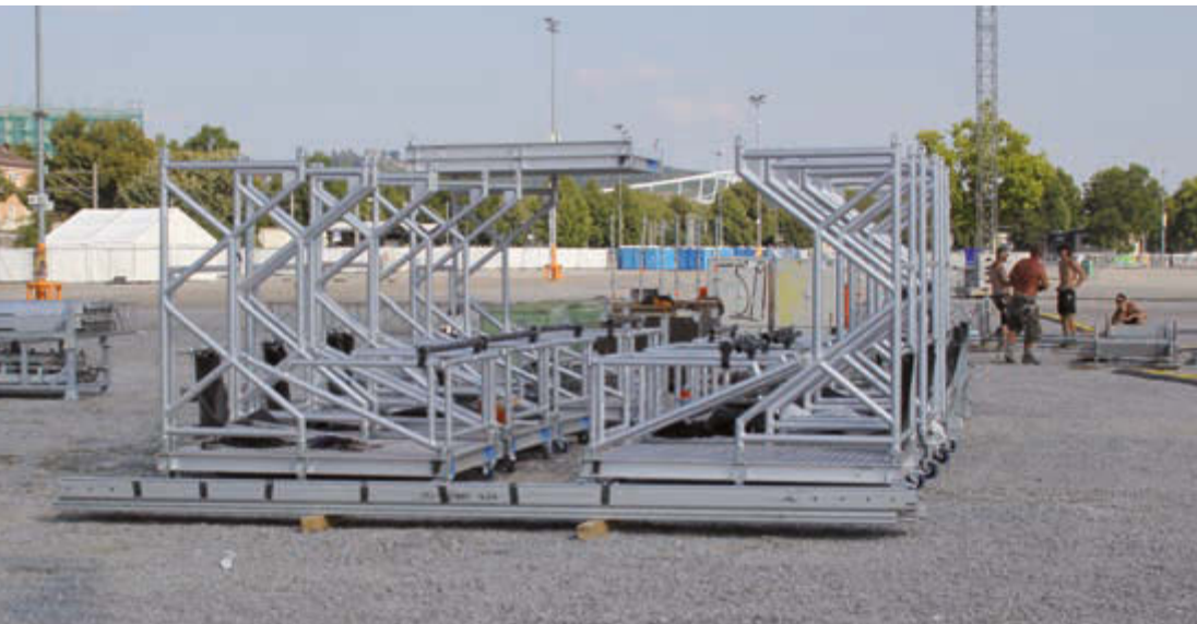
Die „geräumigen“ Spot-Gondeln im Aufbau, ...
