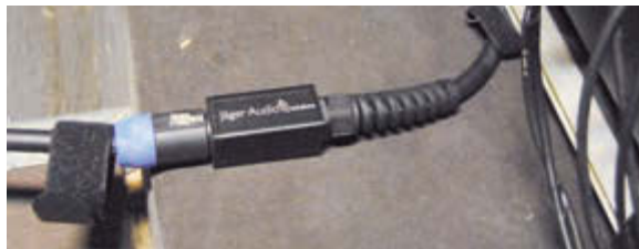
Das Lautsprecher-Multicore verfügt auf der einen Seite über vier separate Speakon-Stecker, die über ein NL8-Kabel zur Breakoutbox geleitet werden
