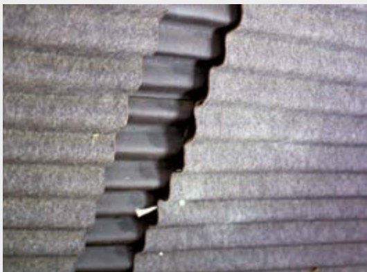
Bild 5: Die abgeschrägte Bühnenrückseite ist mit Wellblech abgedeckt, darüber Filz – laut einem Techniker eine akustische Notmaßnahme, um Reflexionen des Bühnenschalls auf der Steinwand zu reduzieren
